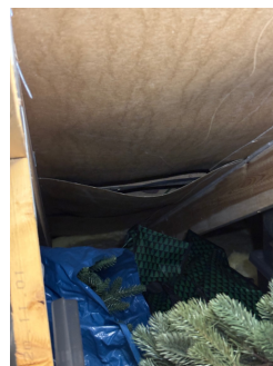
Nedbøyning i su-tak/undertaksplate.
