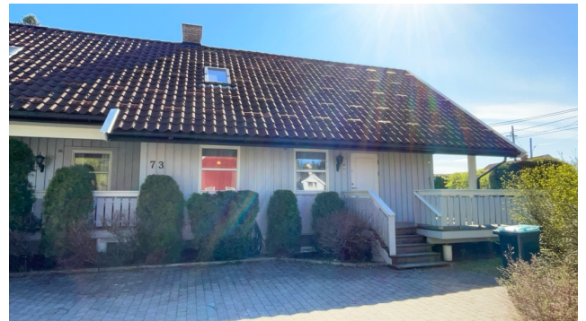
Besiktigelse av taktekke.
