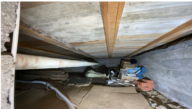
Besiktigelse av kryprom.
