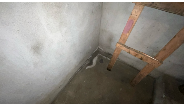
Synlige fuktflammer i kjeller.
