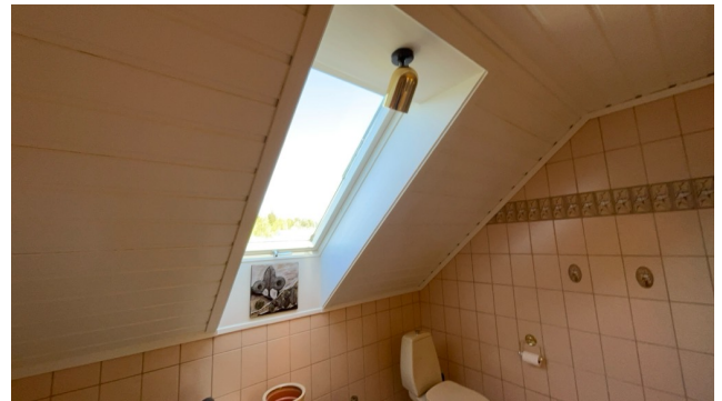
Ingen synlige lekkasjer rundt takvinduer på befaringdagen.
