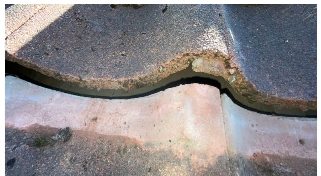
Kontroll av undertak.
