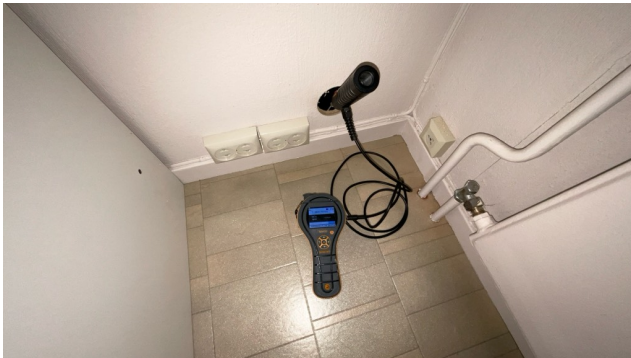
Utført fuktmåling i vegg. Ingen høy fuktprosent ble målt på befaringdagen.
