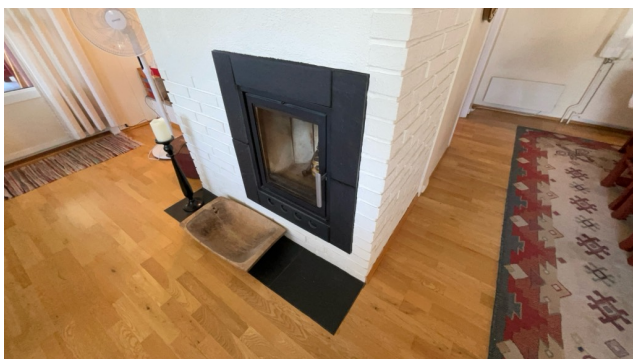
Besiktigelse av ildsted.
