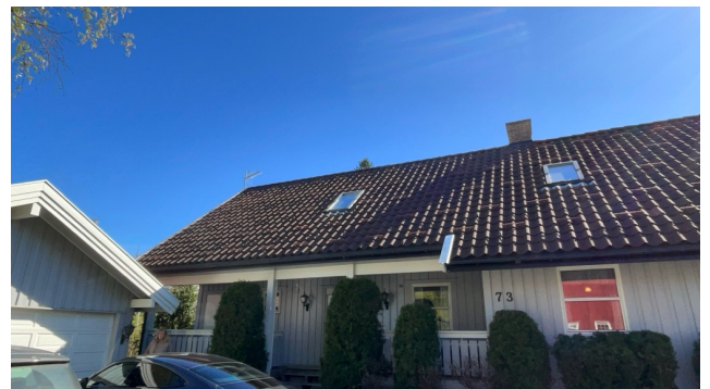
Besiktigelse av taktekke.
