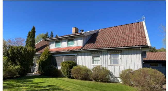
Besiktigelse av taktekke.
