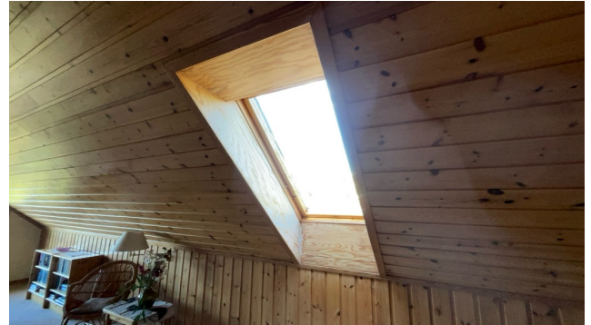
Ingen synlige lekkasjer rundt takvinduer på befaringdagen.
