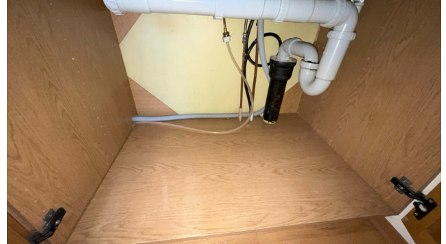
Besiktigelse av røropplegg.
