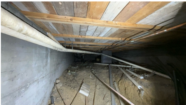
Besiktigelse av kryprom.
