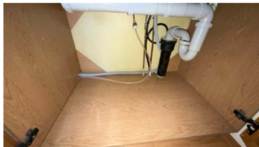
Besiktigelse av røropplegg.
