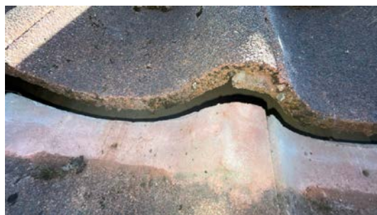
Kontroll av undertak.
