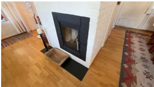
Besiktigelse av ildsted.
