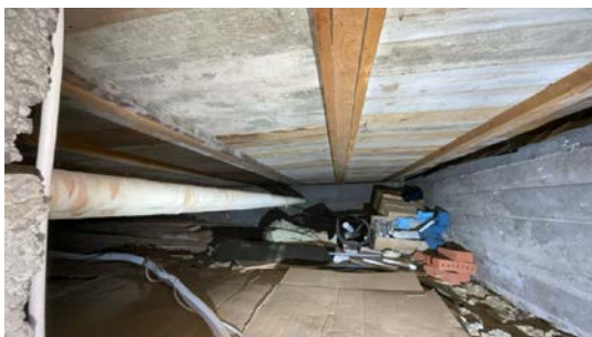
Besiktigelse av kryprom.
