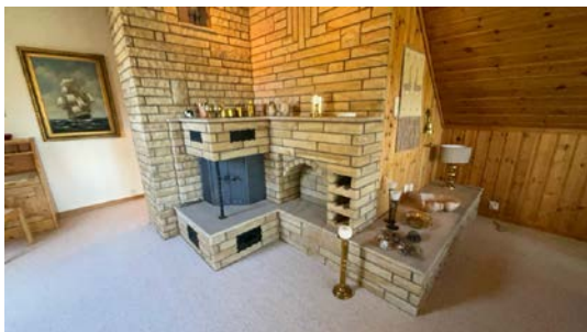
Besiktigelse av ildsted.
