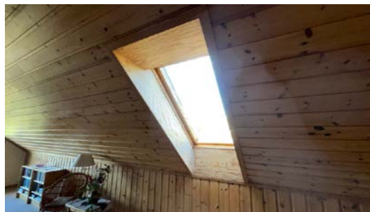
Ingen synlige lekkasjer rundt takvinduer på befaringsdagen.
