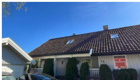
Besiktigelse av taktekke.
