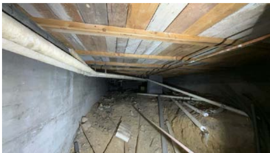
Besiktigelse av kryprom.
