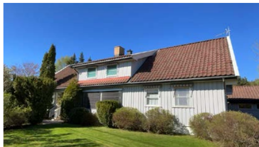
Besiktigelse av taktekke.
