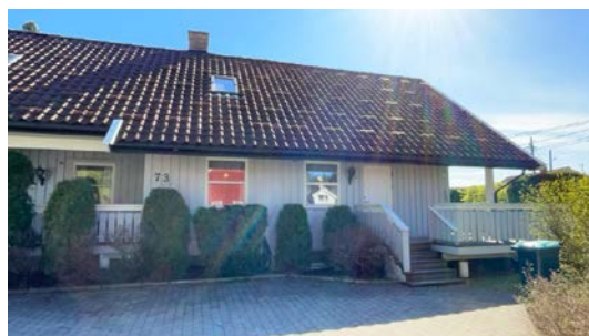
Besiktigelse av taktekke.
