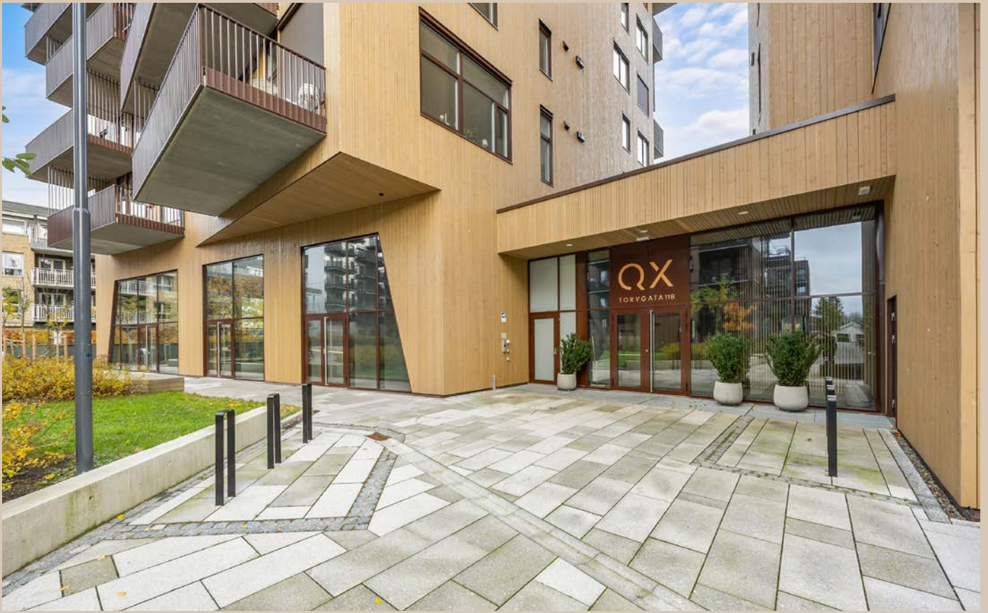
Torgvata 11B var ferdigstilt i 2023.
