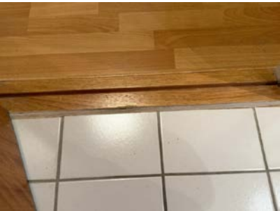
Sprekk i gulvfliser v/ dør.
