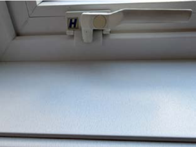
Riss/krakerling i vindustilsetning på hovedsoverom.
