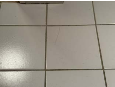
Sprekk i gulvfliser v/ dør.
