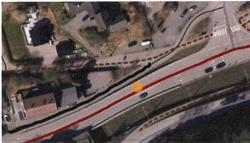
Fig. 1. Flyfoto som viser tilkomst til eiendommen fra offentlig vegnett via privat veg.
