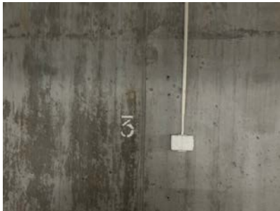
Stikkontakt v/ garasjeplass. Bør ikke benyttes til el.bil lading.
