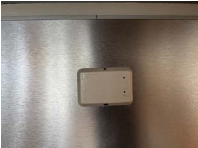
Komfyrvakt v/ kjøkkenventilator.
