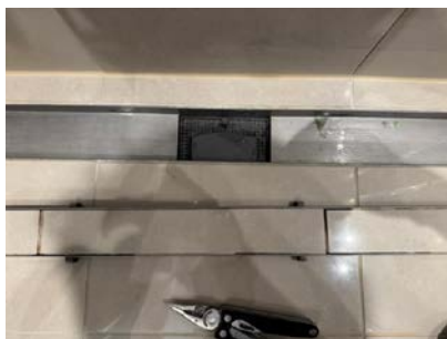
Slukrenne i dusjen.
