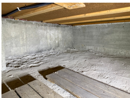
Blindkjeller med grovstøp.
