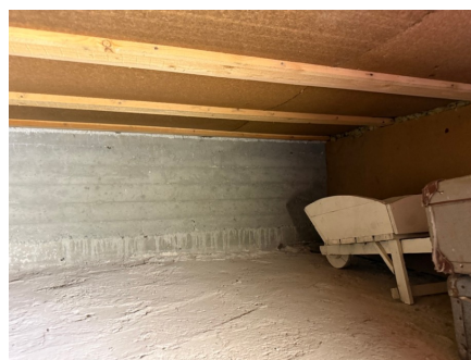
En må krype i blindkjelleren.
