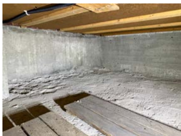
Blindkjeller med grovstøp.
