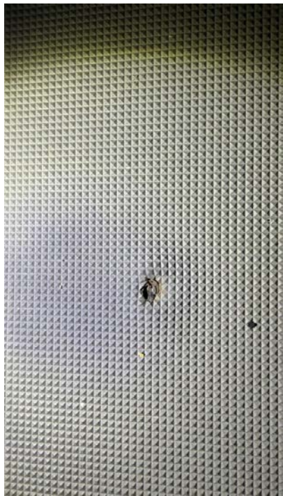
Eksempelbilde av skruerull/ brudd i tettesjikt.
