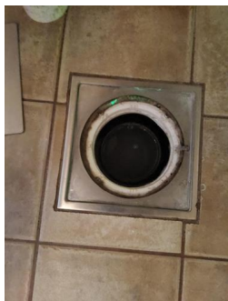
Tettesjiktets tilslutning til sluk - Sluk
