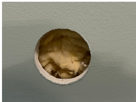
Synlig del av veggkonstruksjon etter hulltaking.
