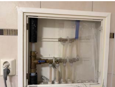
Ingen tegn til fukt/kondens i rør i rør skap. Rør i rør skap bør sjekkes for ev. lekkasje 2 ganger årlig.
