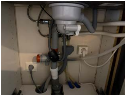
Røropplegg under vask. 3-ETG > STUE/KJØKKEN (26,8 M²)
