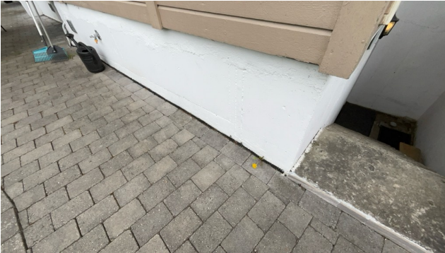
Kontroll av drenering/fuktsikring.
