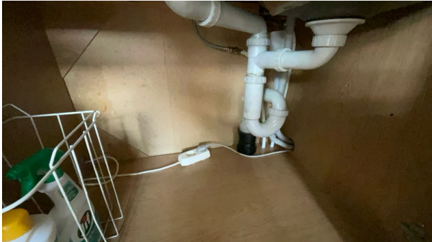
Besiktigelse av røropplegg.
