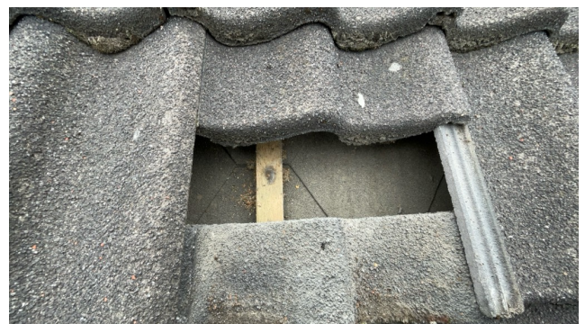
Kontroll av undertak. Undertak av eldre takshingel.
