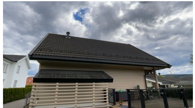
Besiktigelse av taktekke.
