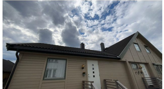
Besiktigelse av taktekke.
