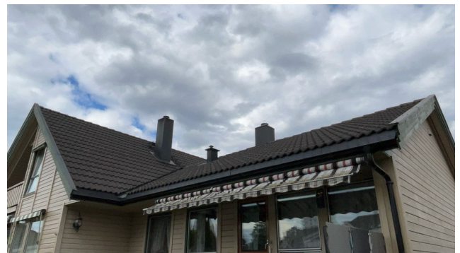
Besiktigelse av taktekke.
