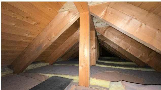
Generell besiktigelse. Noe begrenset tilkomst for total kontroll.
