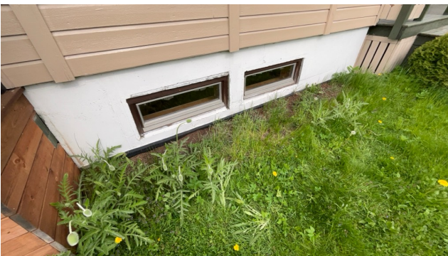
Kontroll av drenering/fuktsikring.
