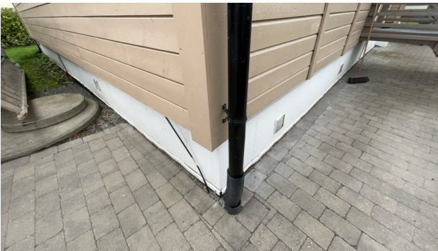
Kontroll av drenering/fuktsikring.
