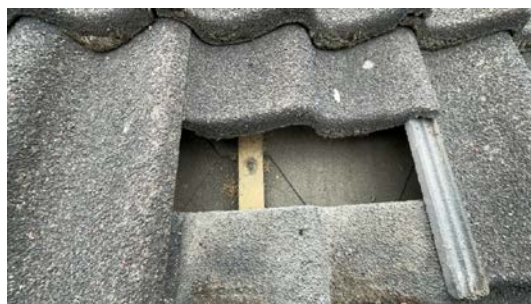
Kontroll av undertak. Undertak av eldre takshingel.
