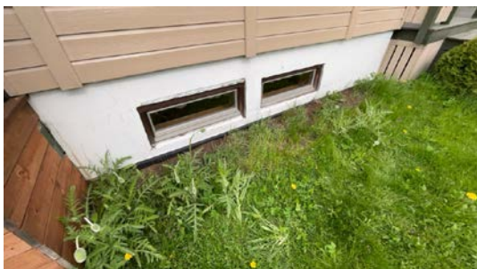
Kontroll av drenering/fuktsikring.
