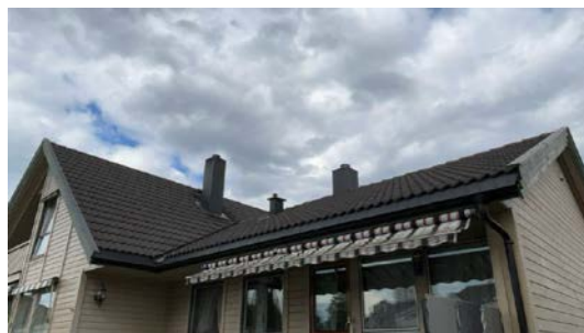
Besiktigelse av taktekke.
