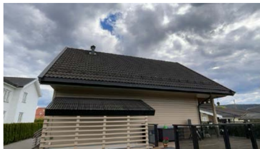
Besiktigelse av taktekke.
