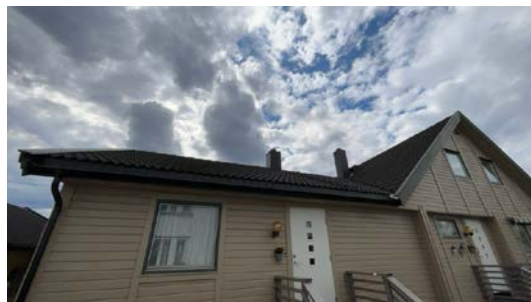
Besiktigelse av taktekke.
