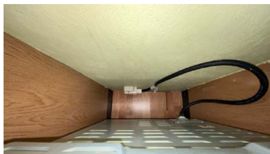
Kontroll bak ovn. Ingen tegn til fuktskader på befaringdagen.
