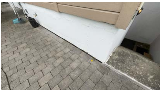
Kontroll av drenering/fuktsikring.
