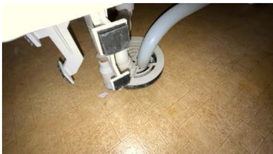
Kontroll av sluk.
