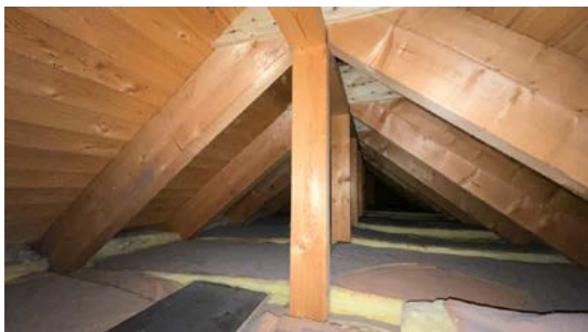
Generell besiktigelse. Noe begrenset tilkomst for total kontroll.
