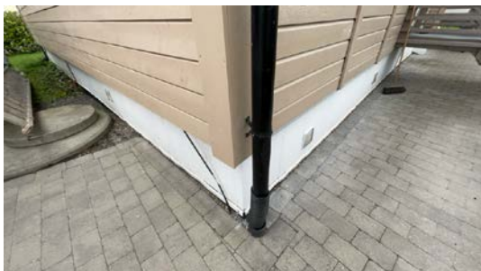
Kontroll av drenering/fuktsikring.
