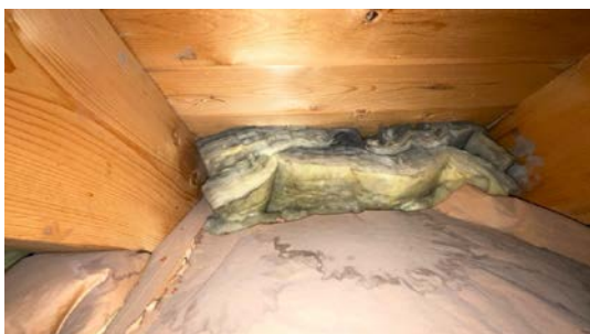
Minimalt med luftespalter på isolert del.
