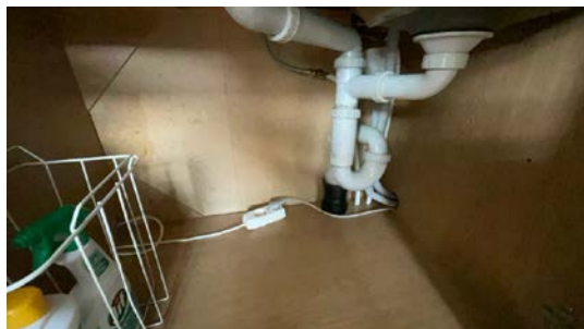
Besiktigelse av rørapplegg.
