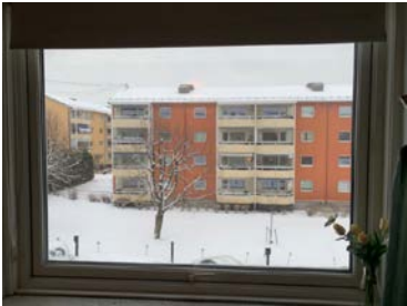
Vinduer med malt treramme
