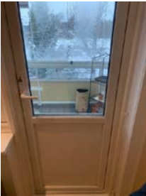
Balkongdør med malt treramme
