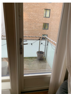
Balkongdør med malt teramme
