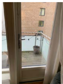
Balkongdør med malt treramme
