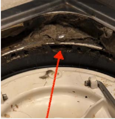
Glippe mellom klemring og sluk.
