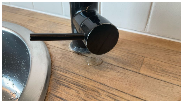
Drypplekkasje fra blandeatteri. Dette punktet alene genererer TG 3.
