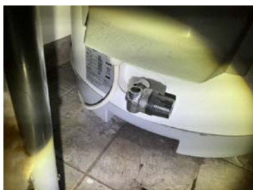
Drypper litt vann fra sikkerhetsventilen
