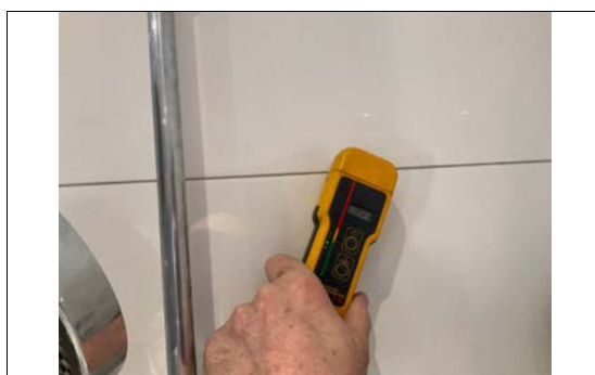
Kontrollsjøk med fuktmåler i dusjsone på bad i 1.etasje.
