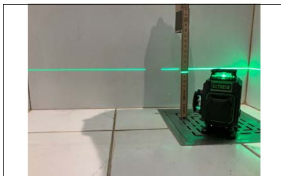
Kontroll av fall på gulv i 1.etasje.
