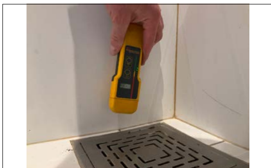
trollsjøk med fuktmåler i dusjsone på bad i 1.etasje.
