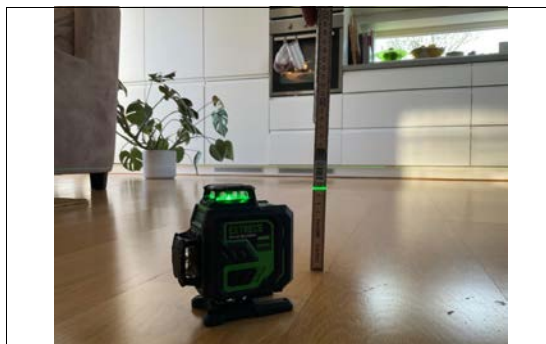
Nivellering av gulv. Kontroll av helling
