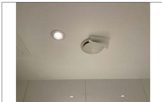
Kontrollsjøk av avtrekk på bad i U.etasje.
