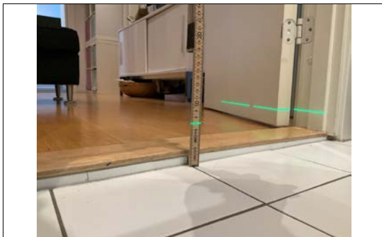
Kontroll av fall på gulv i U.etasje.
