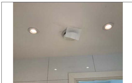
Kontroll av avtrekk på bad i 1. etasje.
