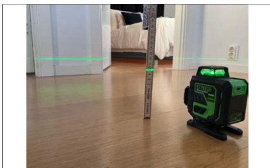
Nivellering av gulv. Kontroll av helling.
