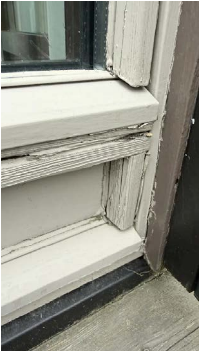
Eksempelbilde av slitasjegrad/ malingsavfluss på utvendig vinduskarm.
