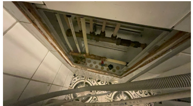
Besiktigelse av røropplegg.
