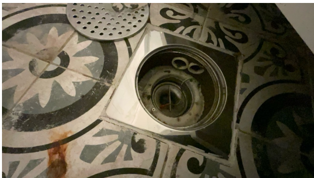
Kontroll av sluk.
