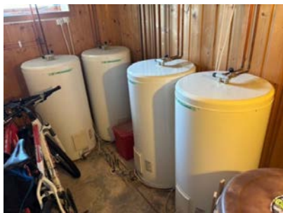
Besiktigelse av bereder.
