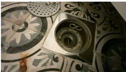
Kontroll av sluk.
