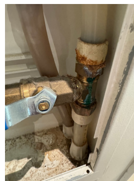
Noe rust på kran. Bør sjekkes av rørlegger.
