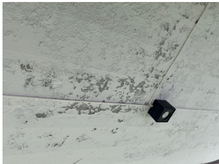
Avflassing maling under betongdekke
