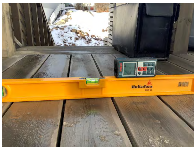
Terrasse i 1. Etasje: Ingen avvik ved trapp mot vest.
