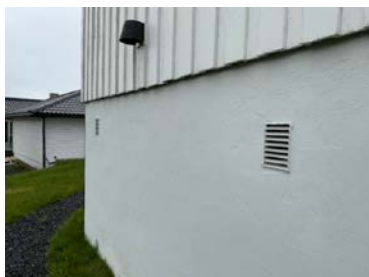
Luftventiler krypkjeller.
