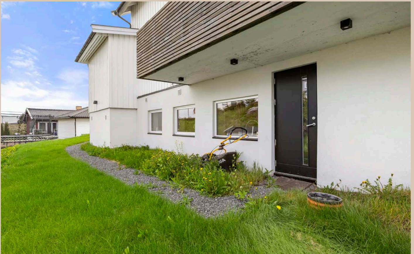
Egen inngang til kjelleretasjen fra hagen.
