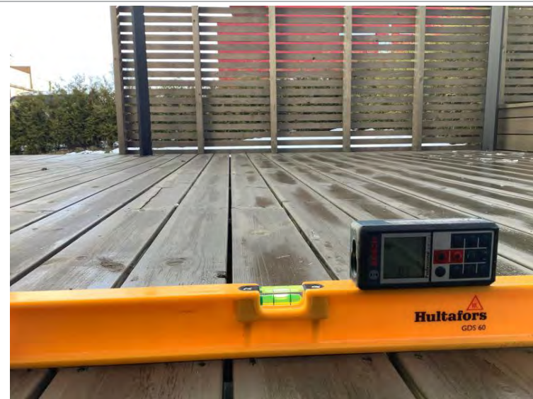
Terrasse i 1. Etasje: Tilnærmet ingen avvik flere steder.
