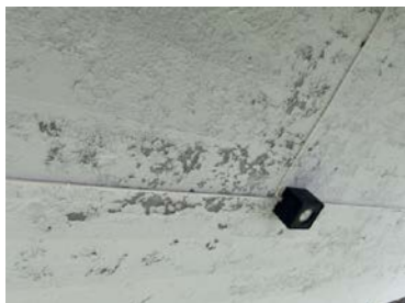
Avflassing maling under betongdekke
