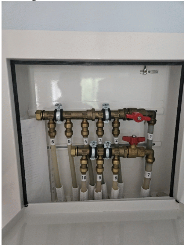
TG ii 6.2 Varmtvannsbereder
