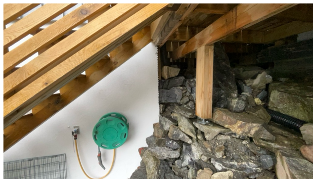
Kontroll av drenering/fuktsikring.
