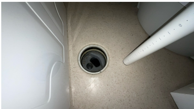
Kontroll av sluk.
