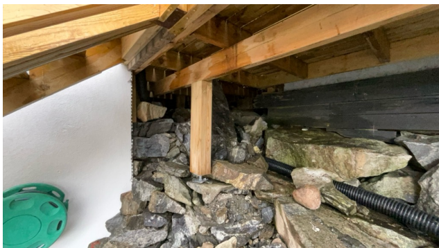
Kontroll av fundament.
