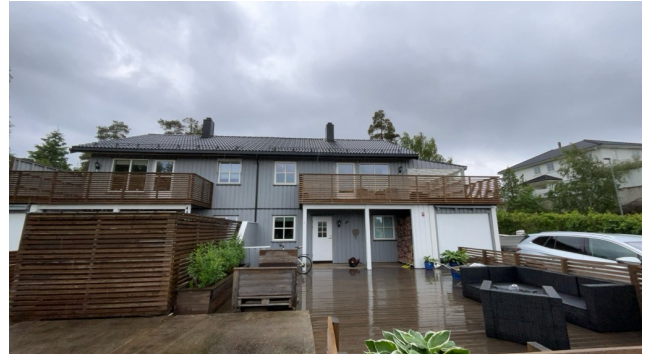
Besiktigelse av taktekke.
