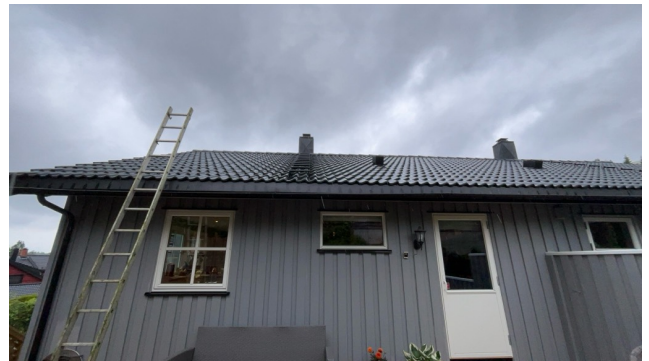
Besiktigelse av taktekke.
