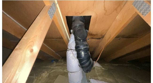
Kontroll rundt rørgjennomføringer.
