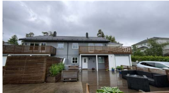
Besiktigelse av taktekke.
