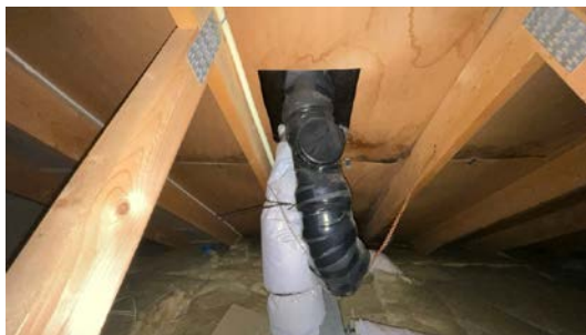
Kontroll rundt rørgjennomføringer.
