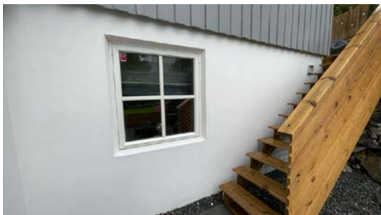
Ingen tegn til setninger på murkonstruksjon på befaringsdagen.
