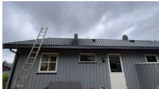
Besiktigelse av taktekke.
