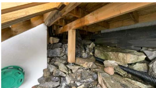
Kontroll av fundament.
