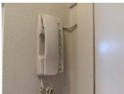
Dørtelefon i entre/gang.
