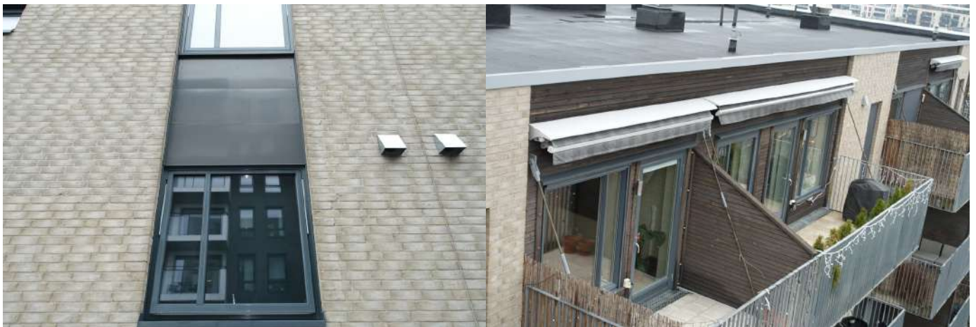
Vinduer med utvendig aluminiumsprofiler.
