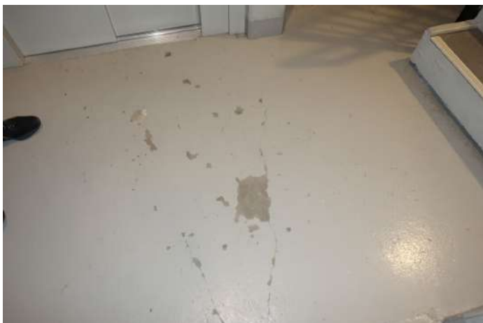
Noe malingsflassing på gulv.
