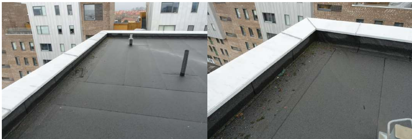
Tak tekket med asfaltbelegg.
