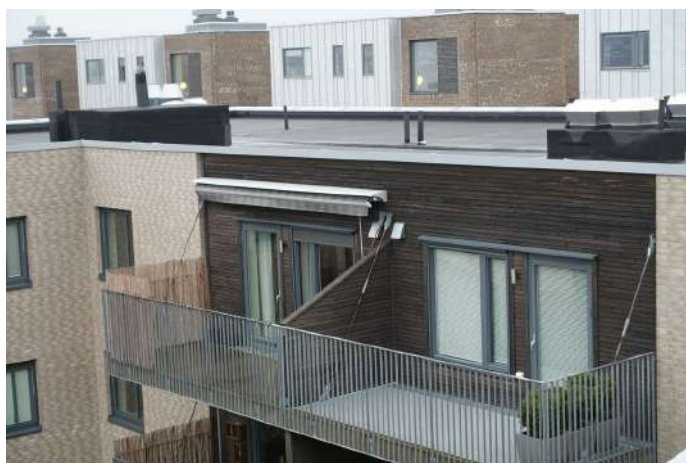
Deler av fasade med trekledning.
