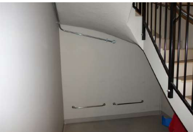
Området er sprinklet.
