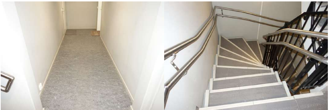
Oppganger med gulvbelegg.
