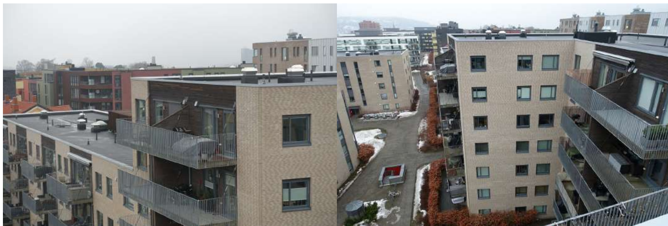
Fasade med konstruksjoner av betongelementer og bindingsverk.
