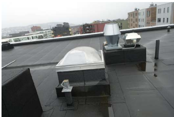
Røykluke, bilde tatt på taket.
