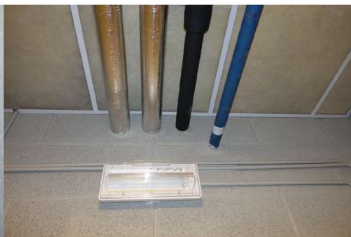
Branntetting rundt gjennomføringer.
