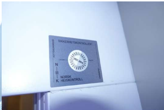
Kontroll utført 2022, neste kontroll siste halvår 2024.
