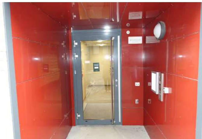
Ramme og karm i eloksert aluminium.
