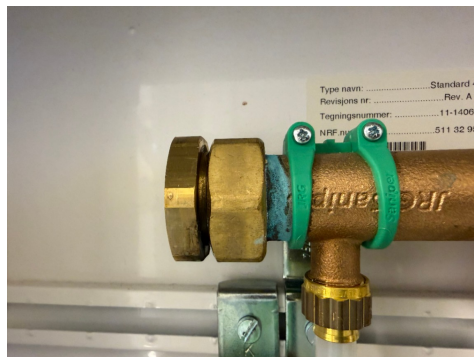
Noe irr på enden av samlestock i rør i rør skap. Ingen tegn til fukt/kondens på befaringsdagen.
