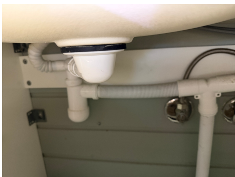
Rørutlegg under servant.
