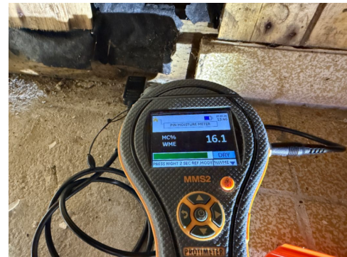
Måling av trefukt/vektprosent.
