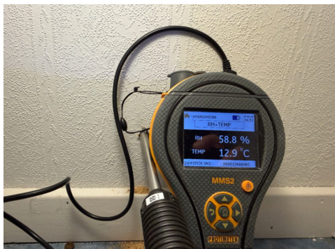
Måling av relativ luftfuktighet.
