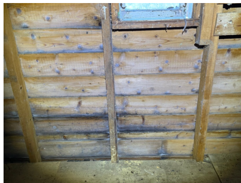
Misfarging på bakside av ytterkledning på endevegg. Synlig på koffertloft.
