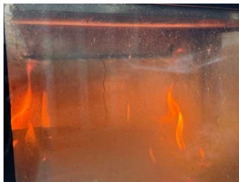
Sprekk i ildfast stein inni peisovn.
