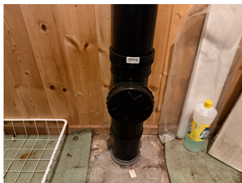
Stakeluke i u-etg.
