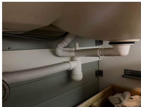
Rørutlegg under servant.
