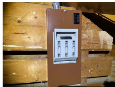
Felles inntaksikring på koffertloft.
