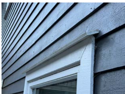
Manglende skråbord over vindu øker faren for fuktinntrenging.
