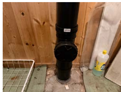
Stakeluke i u-etg.
