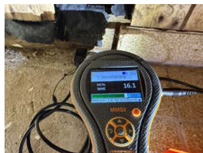
Måling av trefukt/vektprosent.
