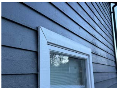
Manglende skråbord over vindu øker faren for fuktinntrenging.
