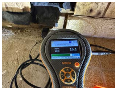
Måling av trefukt/vektprosent.
