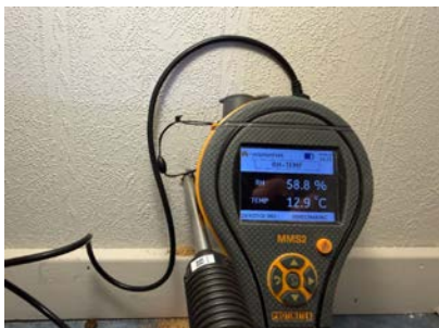
Måling av relativ luftfuktighet.
