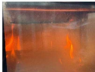
Sprekk i ildfast stein inni peisovn.
