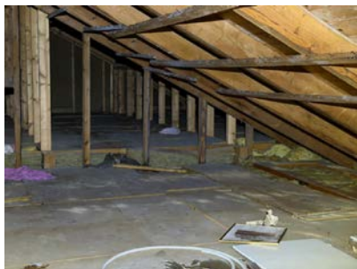
Mittdryss på koffertloft.
