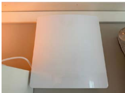
Romventilasjon i stue/kjøkkenet.
