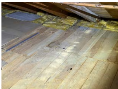
Mittdryss på koffertloft.
