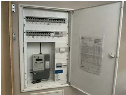
Sikringsskap hoveddel
