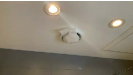
Test av avtrekk. Papiret henger.
