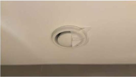
Test av avtrekk. Papiret henger.
