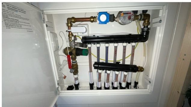
Besiktigelse av røropplegg.
