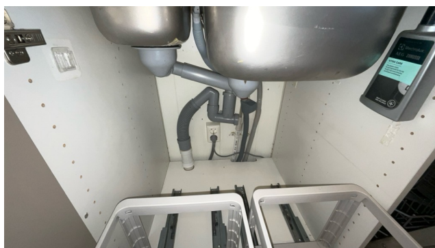
Besiktigelse av røropplegg.
