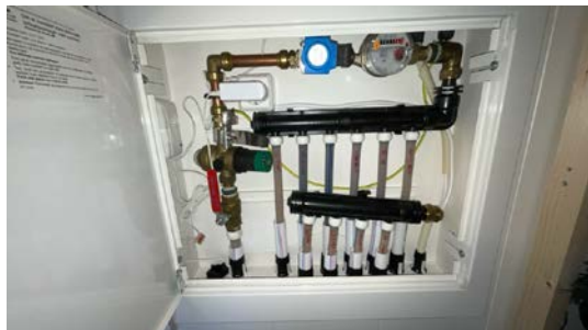
Besiktigelse av røropplegg.
