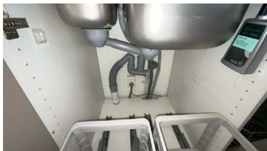
Besiktigelse av røropplegg.
