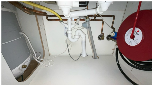
Besiktigelse av røropplegg.
