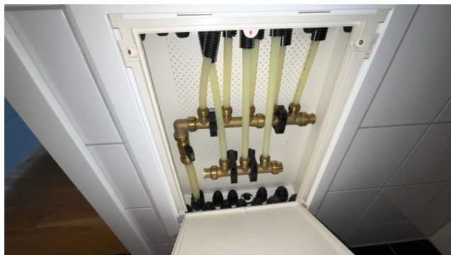
Besiktigelse av røropplegg.
