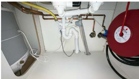
Besiktigelse av røropplegg.
