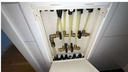
Besiktigelse av røropplegg.
