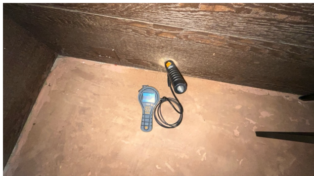
Utført hulltaking på rom under terreng.
