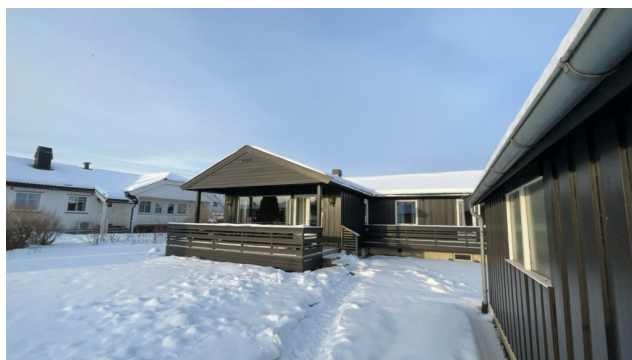
Besiktigelse av taktekke.
