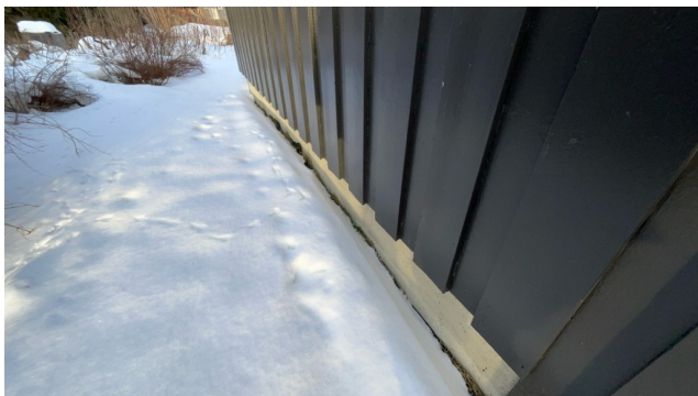
Kontroll av drenering/fuktsikring.
