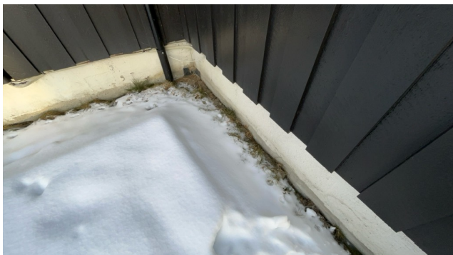
Kontroll av drenering/fuktsikring.
