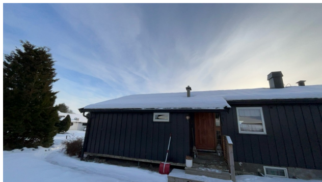
Besiktigelse av taktekke.
