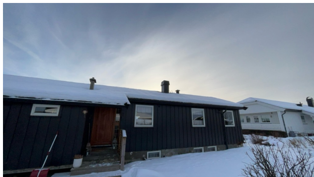
Besiktigelse av taktekke.
