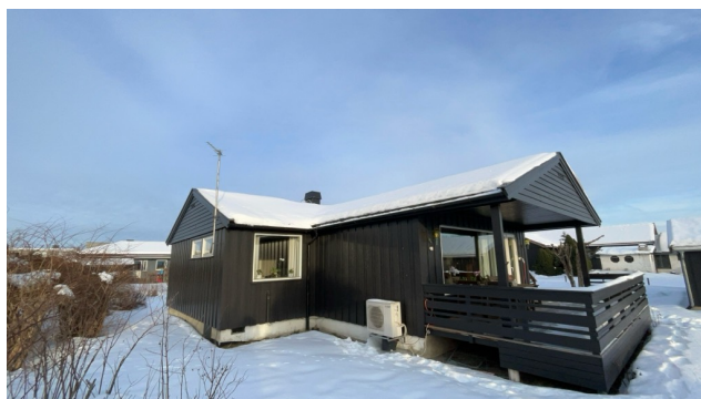
Besiktigelse av taktekke.
