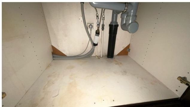
Besiktigelse av rørøpplagg.
