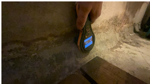
Utført fuktsøk på nedre del av grunnmur.
