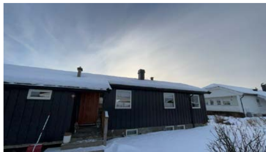
Besiktigelse av taktekke.
