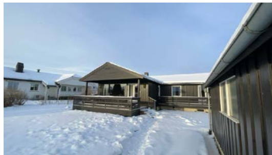
Besiktigelse av taktekke.
