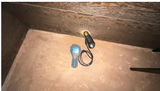
Utført hulltaking på rom under terreng.
