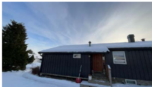
Besiktigelse av taktekke.
