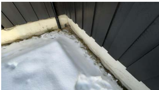
Kontroll av drenering/fuktsikring.
