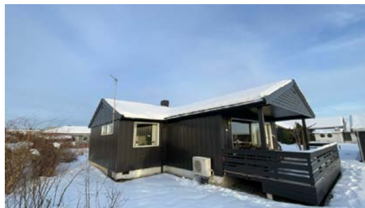
Besiktigelse av taktekke.
