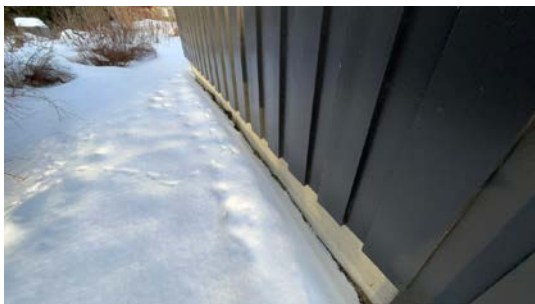
Kontroll av drenering/fuktsikring.
