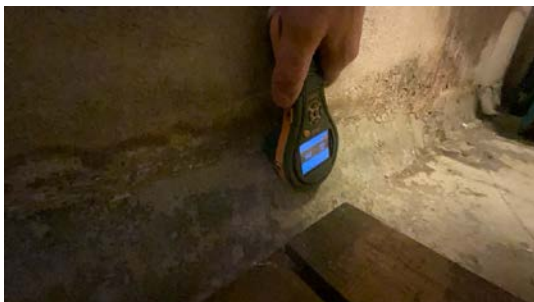
Utført fuktsøk på nedre del av grunnmur.
