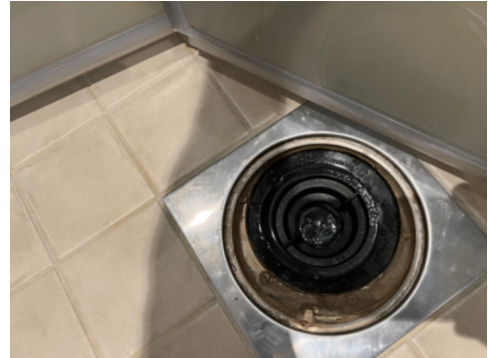
Plastsluk med klemring.
