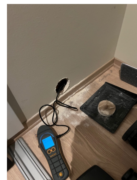
Det ble ikke målt unormale fuktverdier i konstruksjoner.
