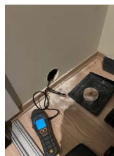
Det ble ikke målt unormale fuktverdier i konstruksjoner.
