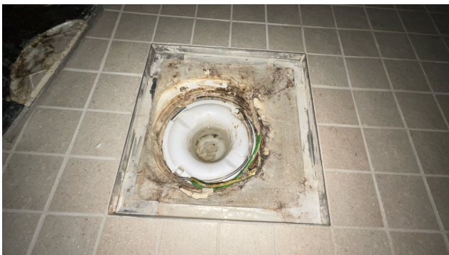
Kontroll av sluk.
