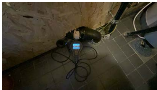
Utført fuktmåling i svill.
